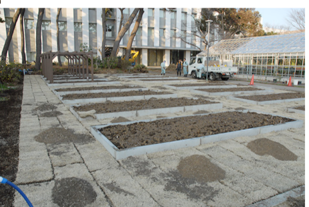
→花壇設置完了。道には芝生を敷きつめてある。
